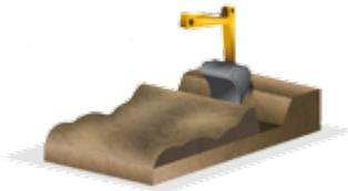
Aushub gemäß Vorgaben durchführen und anschließend das Planum mit einer Rüttelplatte abrütteln.
