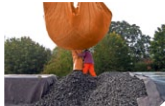
Einbau mit Abladetüchern
